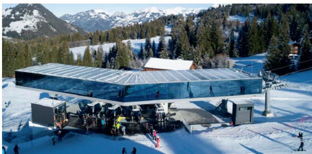
Abb. 6: Die Scheiben der vollständig verglasten Stationen der Saanenlochbahn im Berner Oberland (Gstaad Saanenland) sind eine Weltpremiere und ursprünglich als Projektionsflächen für Information und Animation urbaner Stationen angedacht.
