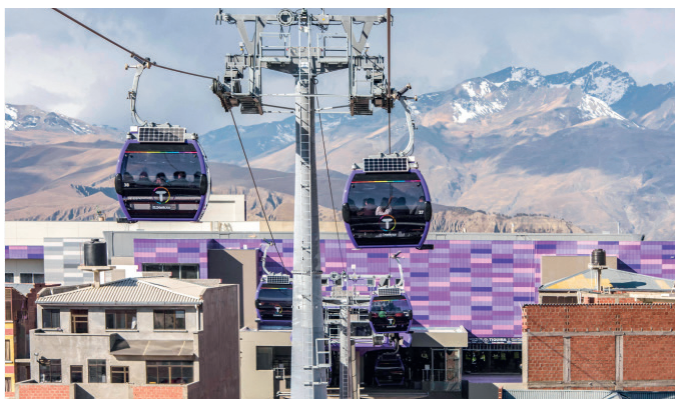
Abb. 7: Die Kabinen der Linea Morada in La Paz sind mit Solarzellen bestückt zur Versorgung der Kommunikation und Beleuchtung an Bord.
