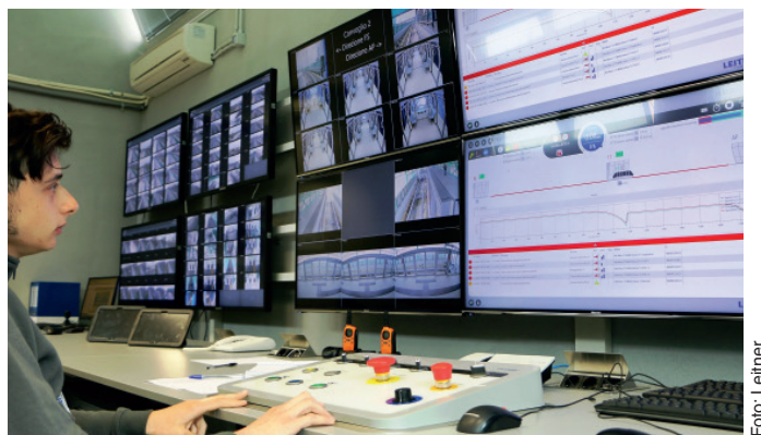
Abb. 8: Blick in den übersichtlichen Kontrollraum des Pisa People Movers.
