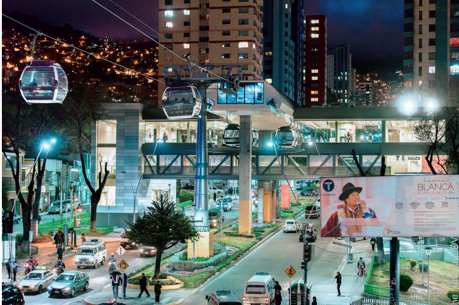
Abb. 1: Den Grünstreifen in der Fahrbahnmitte nutzt die 2018 eröffnete Linea Blanca des Mi Teleférico-Systems in La Paz als Mastenstandort.
